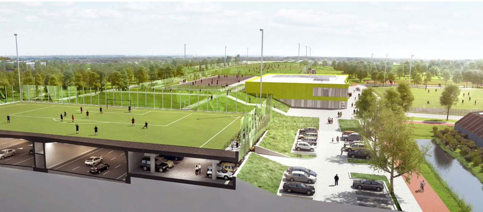
Ondergronds bouwen geeft bovengronds ruimte. Zoals op het dak van de Ketheltunnel.
